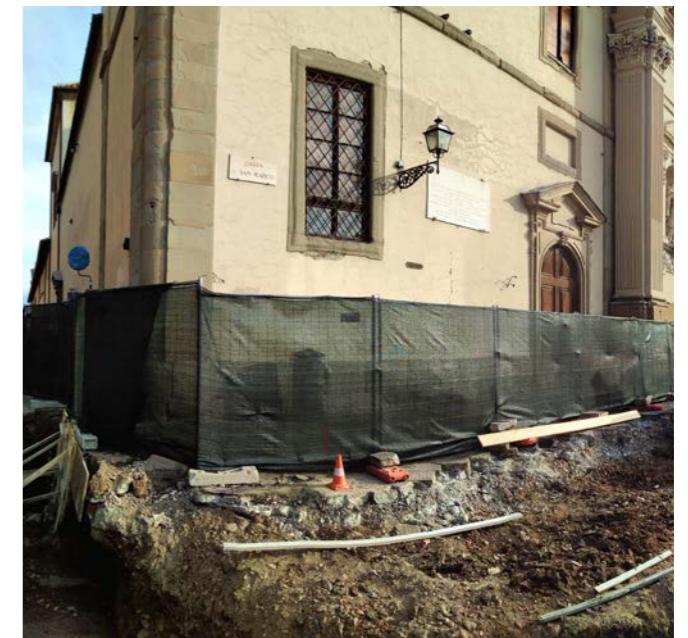
Lavori ante operam: scavo per inserimento pannelli antivibrazioni NoViDamp a protezione dalle vibrazioni prodotte dal transito di tram, bus e mezzi pesanti della Basilica di San Marco in Firenze
