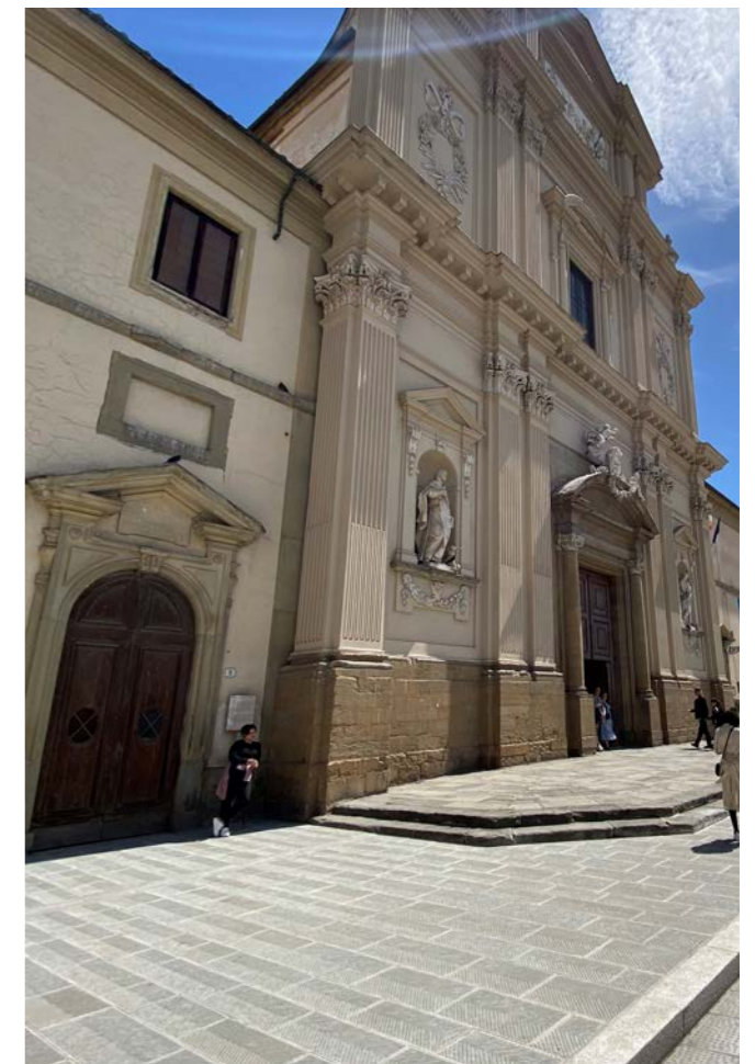
Piazza San Marco (Firenze) a installazione completata
